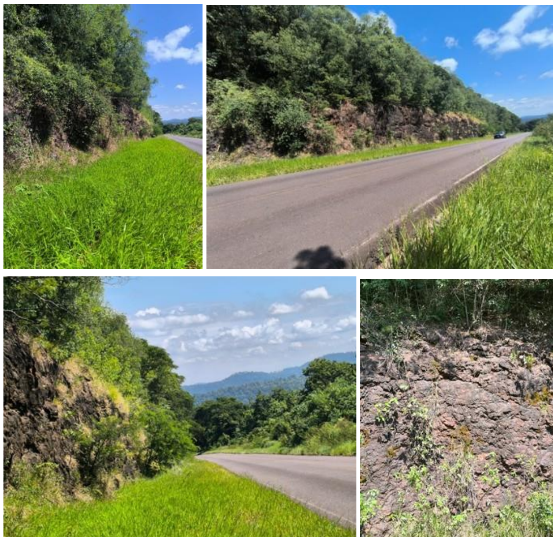
Figura 6. Fotos del tramo comprendido entre las progresivas 36+280 y 40+780 de la Ruta Provincial N.º 17, correspondiente al sector proyectado para la ejecución de la tercera trocha.
